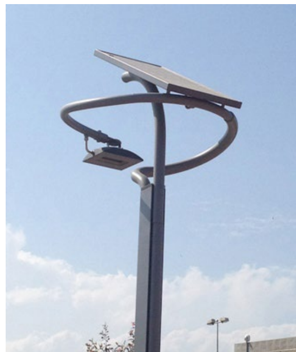
Fig. 477 Farola fotovoltaica
